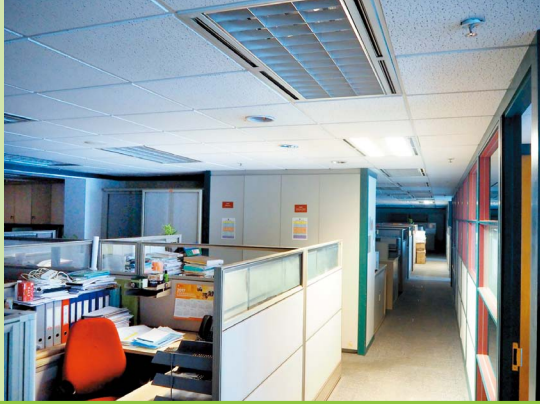
Lighting control timer system 時控照明系統
