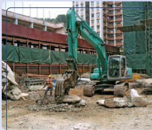
On-site sorting of demolition waste 工地內將拆卸廢物分類
