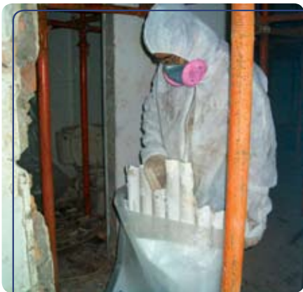
Asbestos abatement work 消滅石棉工作
