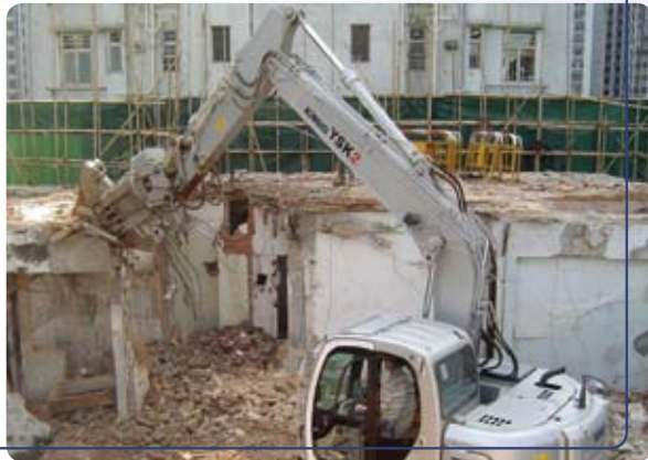
Hydraulic crusher for demolition works 採用油壓鋼剪進行拆卸工程
